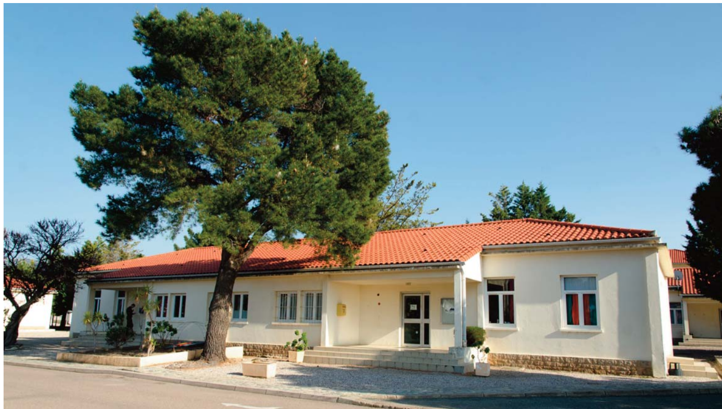
Le bâtiment du BEH.
